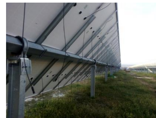
Ilustración 75 Detalles del diseño actual de plantas solares fotovoltaicas. Hincado mediante pilares sin cimentación
